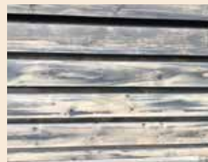
Synliga torkmärken från impregneringslösningen
