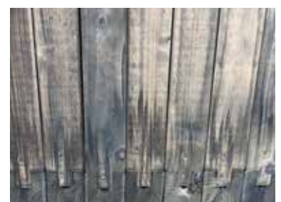
Synliga torkmärken från impregneringslösningen
