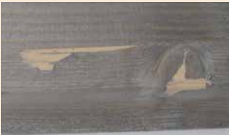
Ytbehandlad med träspackel på doppimpregnerat trä
