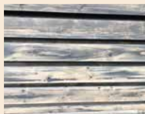
Видимые следы высыхания пропиточного раствора
