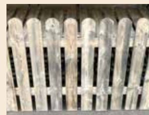
Видимые следы высыхания пропиточного раствора
