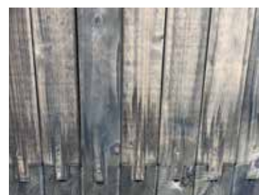
Видимые следы высыхания пропиточного раствора
