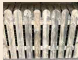
Synlige tørkemerker av behandlingsløsningen
