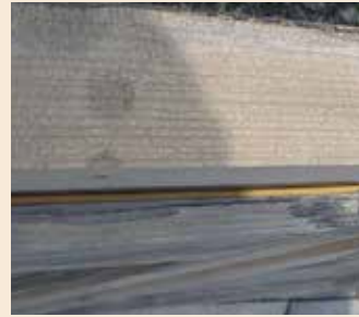
Dyppevæske kommer ikke frem til alle overflater
