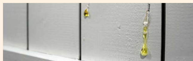
Può verificarsi trasudamento di resina.
