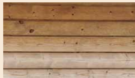
La parete di una cabina marrone immersa che è stata all'aria aperta per quattro anni senza ulteriori finiture. La parte esposta al sole è molto sbiadita.
