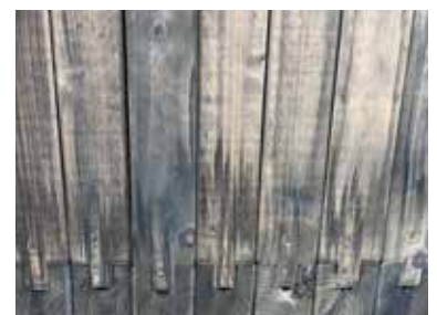
Marques de séchage visibles de la solution de traitement
