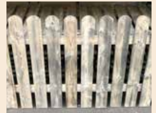
Marques de séchage visibles de la solution de traitement
