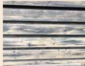
Marques de séchage visibles de la solution de traitement
