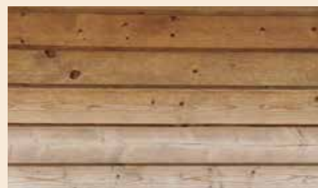
Mur d'un abri traité marron resté 4 ans en extérieur. La partie exposée au soleil est fortement décolorée.
