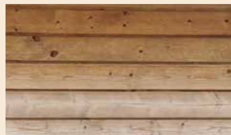
Pelkällä ruskealla upotusliuoksella käsitellyn piharakennuksen seinä neljä vuotta käsittelyn jälkeen. Auringonvalolle altistuneet pinnat ovat haalistuneet selvästi.
