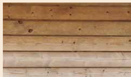
Pared de una cabaña con tratamiento por baño de inmersión marrón que ha estado a la intemperie sin recubrimiento adicional. La parte expuesta al sol está muy descolorida.
