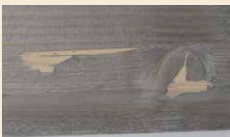
Relleno con masilla para madera
