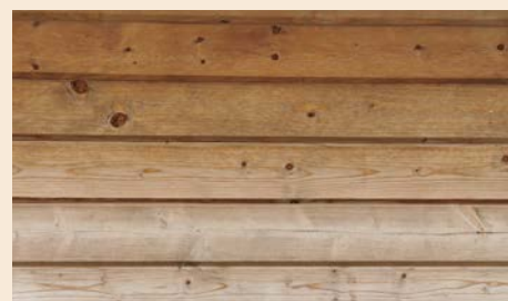
Braun tauchgründierte Hauswand ohne zusätzliche Decklackierung nach vier Jahren. Der dem Sonnenlicht ausgesetzte Teil ist stark ausgebleicht.
