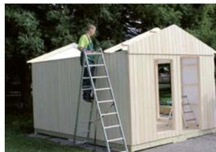
**Couverture du toit avec feutre bitumé ou shingles**
