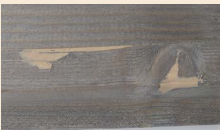
Overflate ferdigbehandlet med trefyll på dyppet trevirke
