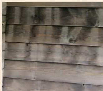
Fargevariasjoner forårsaket av avstandsstenger
