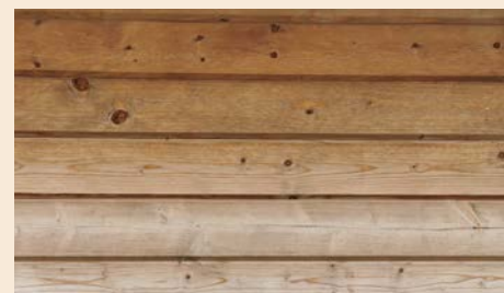
Veggen til en brundyppet hytte, som har vært utendørs i fire år uten ytterligere etterbehandling. Delen som er utsatt for sol er kraftig falmet.
