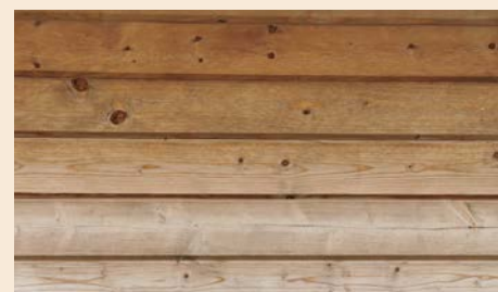
Стена садового дома с коричневой пропиткой, которая четыре года простояла под открытым небом без дополнительной обработки. Часть на солнечной стороне сильно выцвела.
