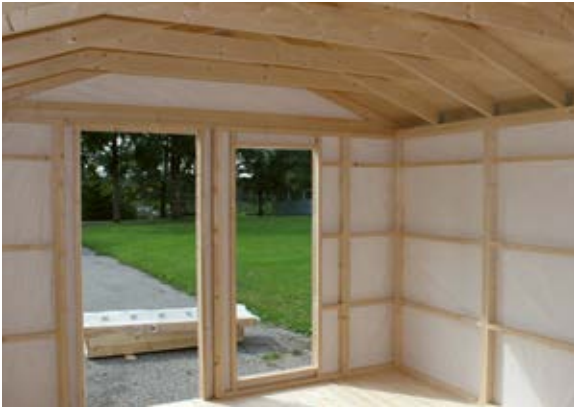
Innenansicht, Wände mit Windschutzfolie
