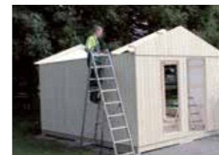
Montering av taksperrer og takbord Prefabrikkerte taksperrer og gavler gjør monteringen enkel. 19 mm takbord. 1 h 30
