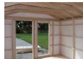
70 mm reisverk, innvendig kledd med vindsperre
