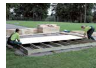
Montering av fundamentramme og gulv Trykkimpregnert ramme med 19 mm gulvbord. 45 min
