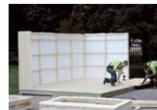
Montering av veggelementer Ferdige veggelementer med vindsperre. 1 h
