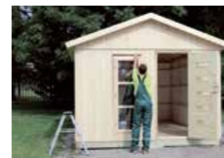
Montering av dører og vinduer Doble vinduer gir god isolasjon. Alle vinduer kan åpnes. 1 h
