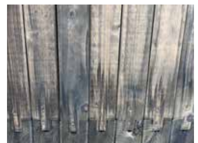
Marcas visibles de secado de la solución de tratamiento
