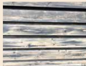
Marcas visibles de secado de la solución de tratamiento
