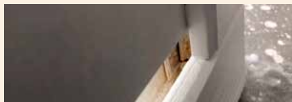
La pintura no llega a todas partes.
