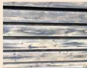
Sichtbare Trocknungsspuren der Behandlungslösung
