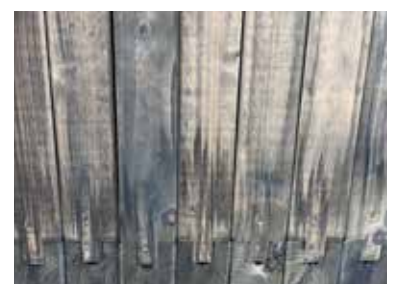
Sichtbare Trocknungsspuren der Behandlungslösung
