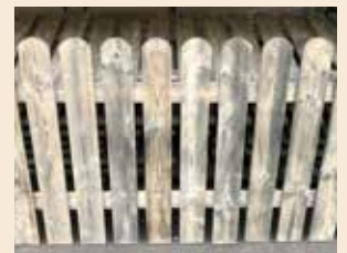
Sichtbare Trocknungsspuren der Behandlungslösung
