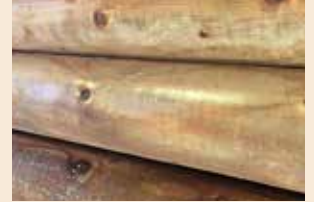
Ruskea väri ei ole päässyt tunkeutumaan kunnolla tolppiin.
