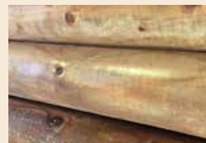
Коричневой пропитке сложно проникать в упакованную оцилиндрованную древесину.
