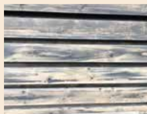
Видимые следы высыхания пропиточного раствора
