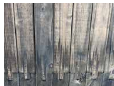
Видимые следы высыхания пропиточного раствора
