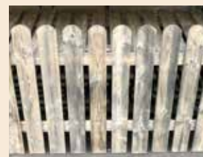
Видимые следы высыхания пропиточного раствора
