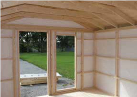
Innenansicht, Wände mit Windschutzfolie
