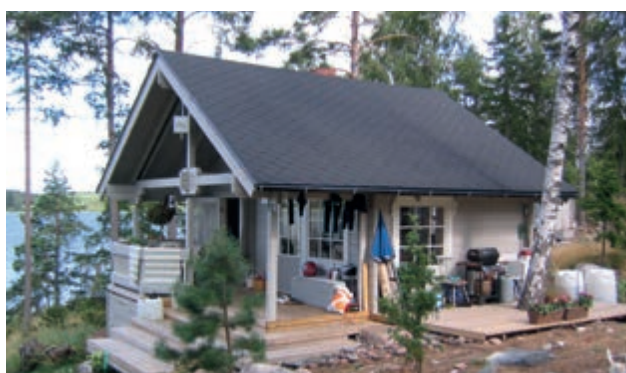
TOIT À DEUX PANS + SHINGLES
